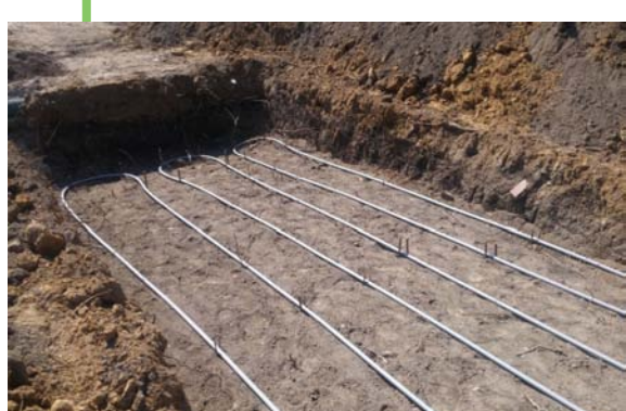
campo geotermico orizzontale profondità 2,0 m
